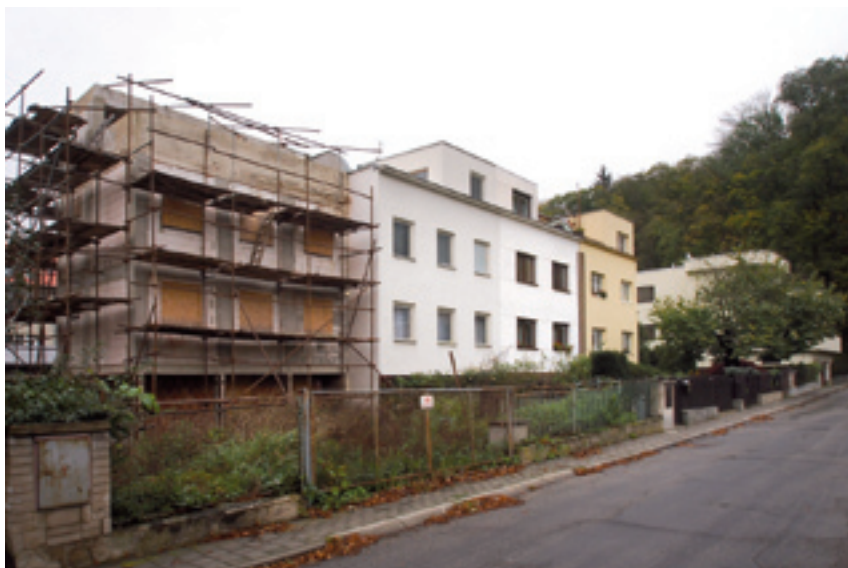
Kolonie Nový dům v Brně, současný stav domů 13 a 12 J. Víška (ul. Drnovická 10–8) a domů 11 a 10 M. Putny (ul. Drnovická 6) a H. Foltýna (ul. Drnovická 4), vzadu dům 9 J. Krohy (ul. Drnovická 2) (foto D. Černoušková, říjen 2014).
