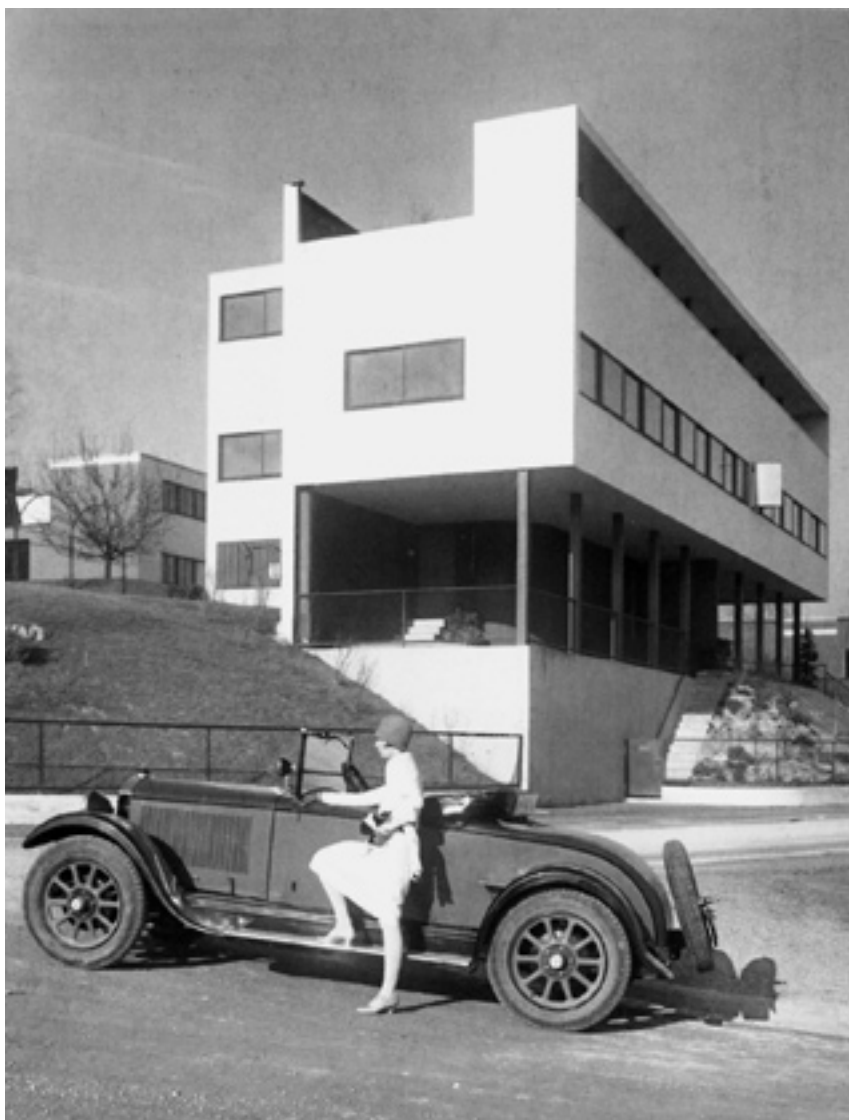
Sídlíště Weissenhof ve Stuttgartu, Le Corbusier a Pierre Jeanneret, domy 14–15 (ul. Rathenastrasse 1–3, dnes sídlo Muzea Weissenhof). Propagační foto: Foto-archiv Mercedes-Benz, a. s., Stuttgart. Repro pohlednice: Muzeum Weissenhof ve Stuttgartu.
