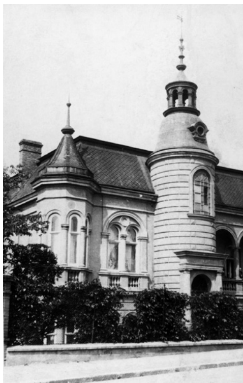
Uliční průčelí vily Brandstätter, ulice Černopolní 41 / Street front of the Brandstätter House at Černopolní 41, ca. 1905–1906 // Archiv SDC-VT
