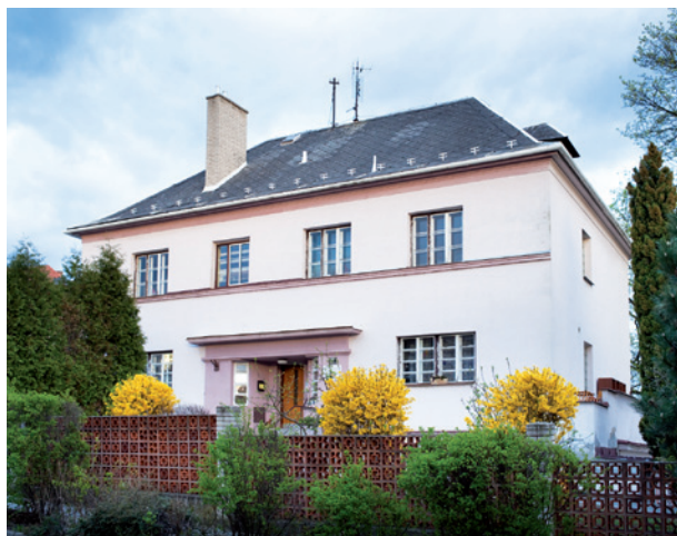
Uliční průčelí vily Himmelreich, ulice Schodová 18 / Street front of the Himmelreich House at Schodová 18, 2011 // Archiv SDC-VT // Foto David Židlický
