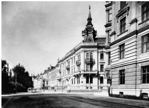
Rodinné a činžovní vily v ulici Drobného s nárožím ulice Antonína Slavíka (stavitel F. A. Dvořák a F. Pawlu) / Private and apartment houses in Drobného Street with the corner of Antonína Slavíka (builders F. A. Dvořák and F. Pawlu), ca. 1910 // Archiv SDC-VT
