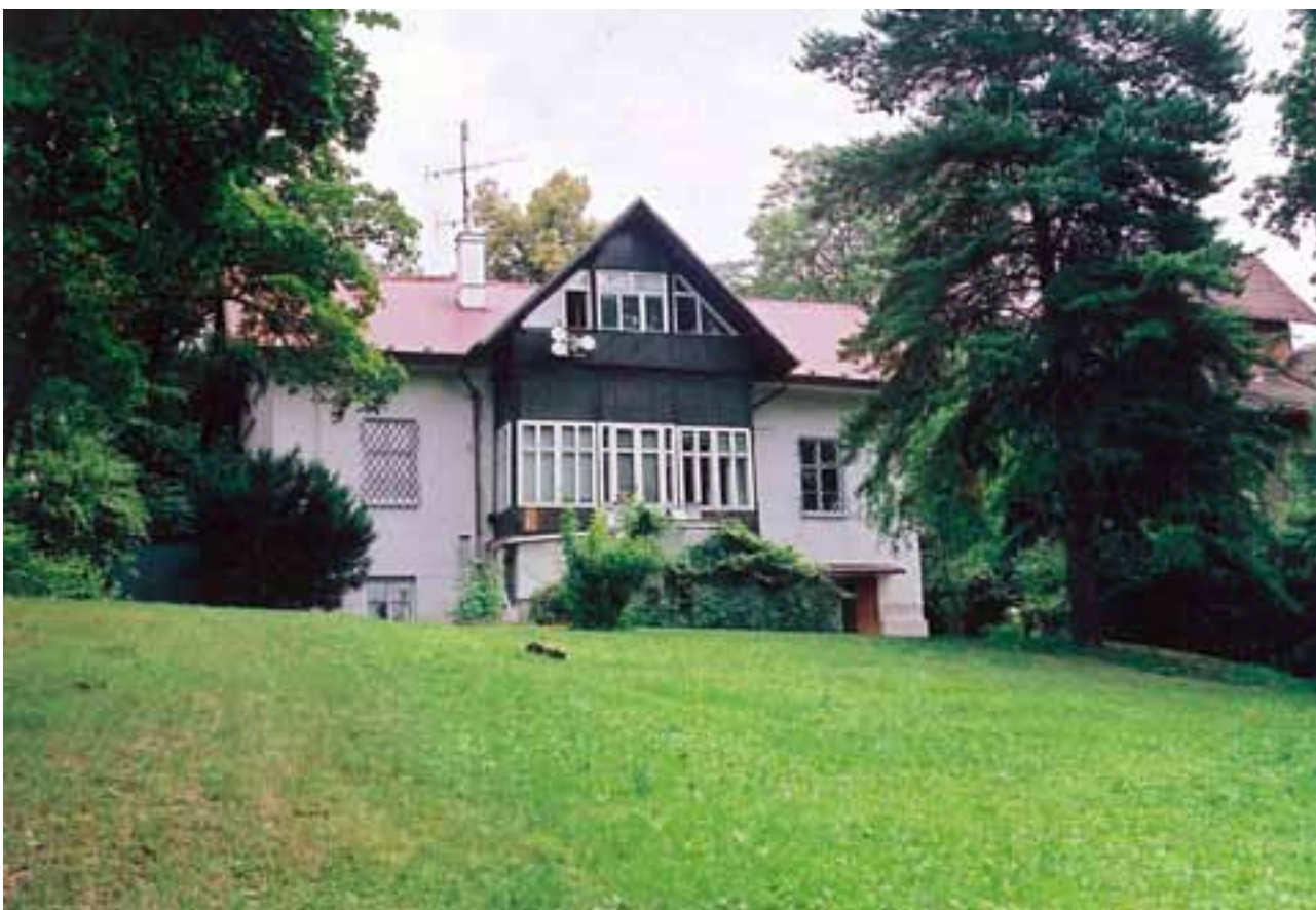
Giskrova vila na Drobného 28, průčelí k ulici Drobného
