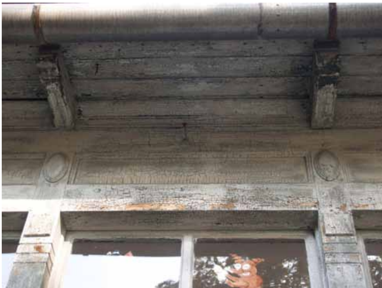
detaily konstrukce a podlahy dřevěné verandy u hlavního vstupu do vily
