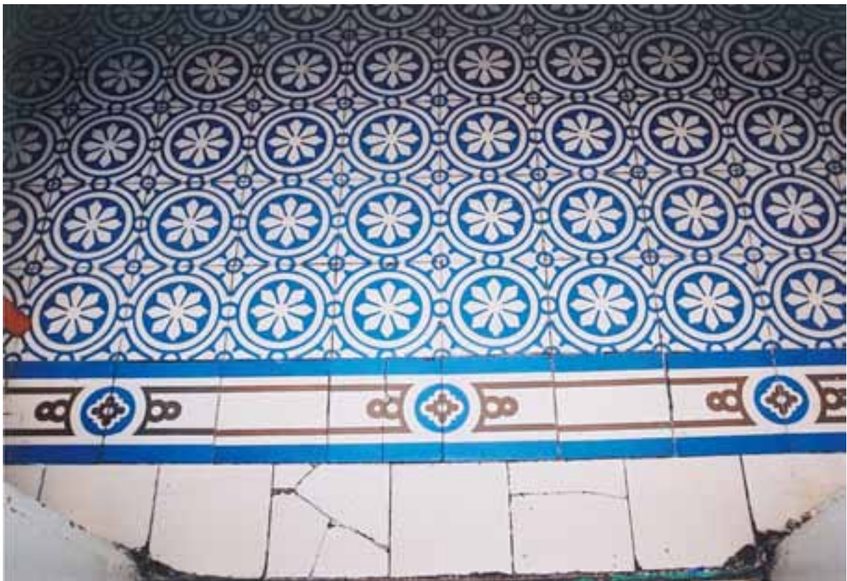
kuchyň v přízemí (m.č. 104) – dlažba
