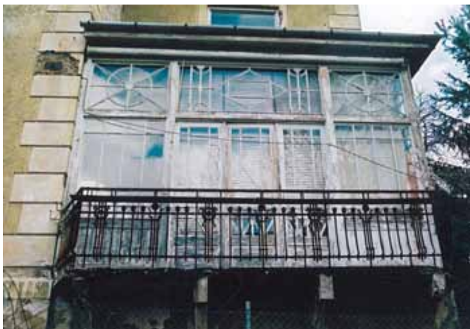
jihozápadní průčelí vily - dřevěná veranda; štít s balkónem; detail litinového zábradlí balkónu v patře
