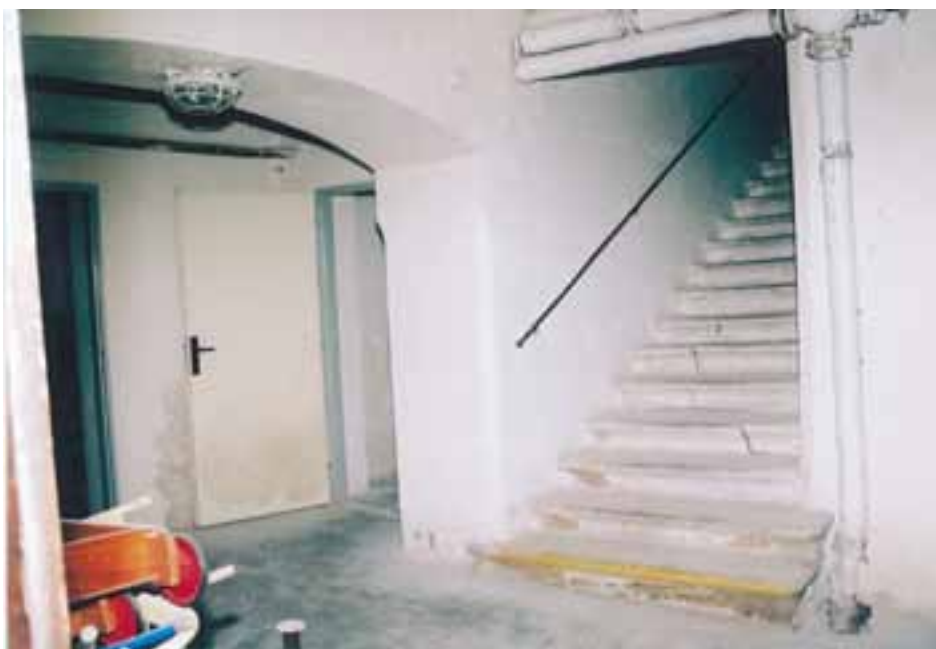
schodiště do suterénu; suterénní prostory
