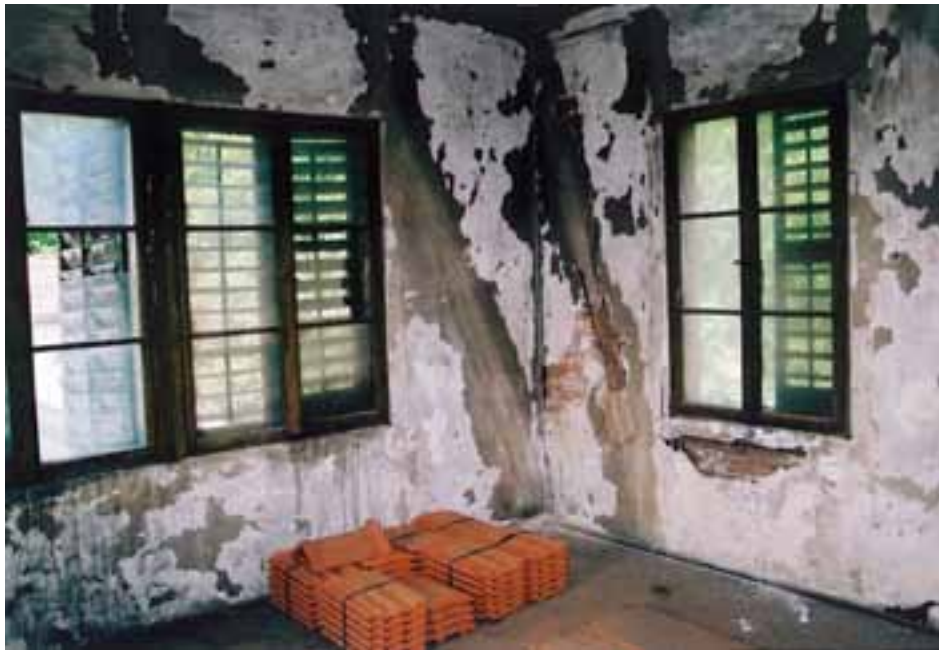
obytný prostor v „Arnoldově věži“; půda nad „Arnoldovou věží“
