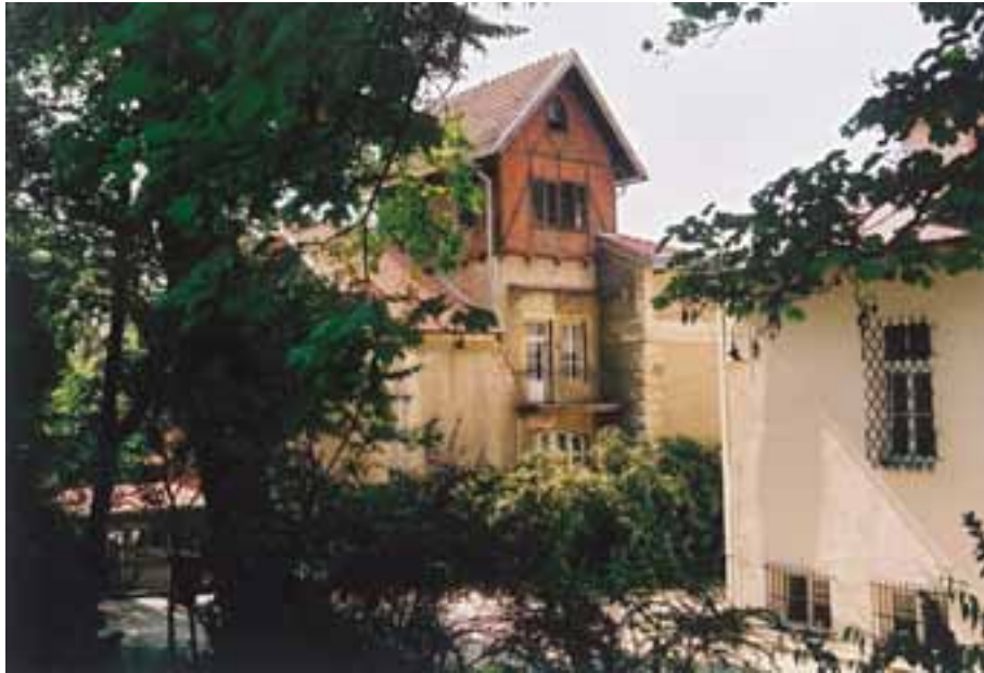
severozápadní průčelí vily, vlevo někdejší Giskrova vila; detail severozápadního průčelí; detail štítu severozápadního průčelí
